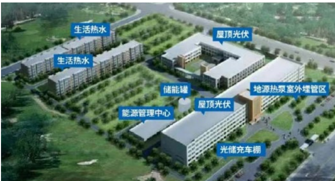
“近零碳”园区示范项目
