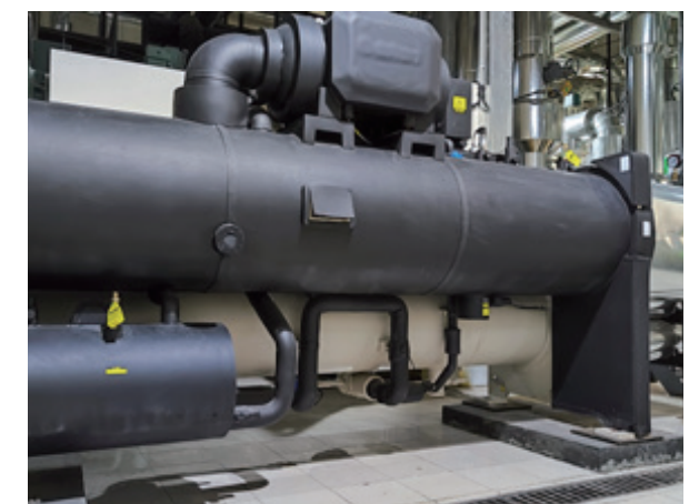
新加装的 150 冷吨冷机
