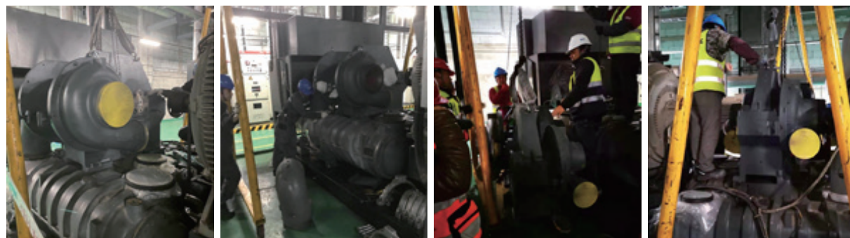
京东方北京第 5 代 TFT-LCD 生产线实施 CDA 系统节能改造
