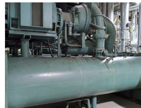
已有的 750 冷吨冷机
