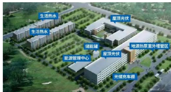
“近零碳”园区示范项目
